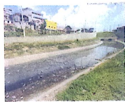
A construção de canais de concreto no aterro de Igarapés também aumenta o calor
